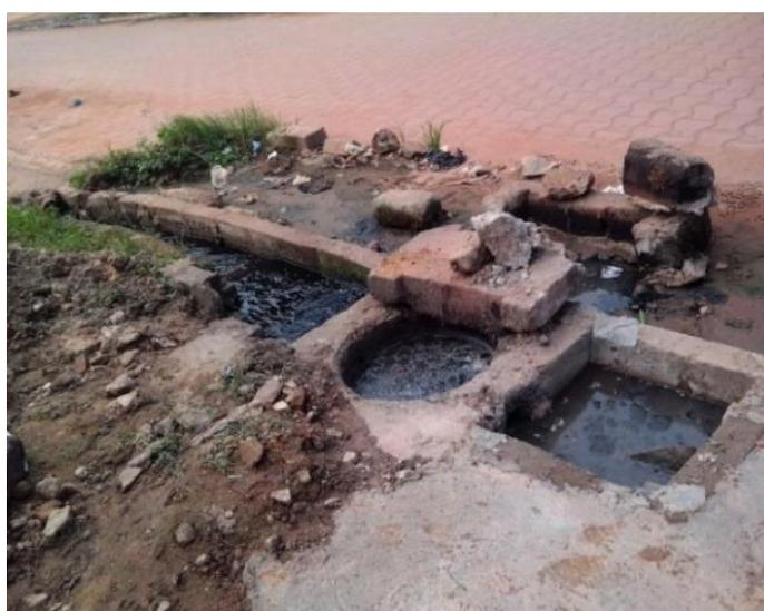
**Photo 6-3 : Saturation des réseaux d'assainissement à San-Pédro dans le quartier Poro 1**
