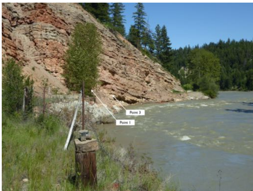
Figure III.24 : Vue d'ensemble du gîte de Ochre Bluffs, Tulameen après les crues de mars 2022. Photo prise le 6 juin 2022 E. Chalmin
